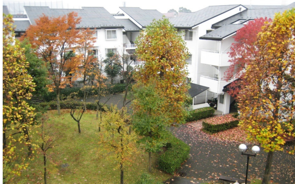
エステート鶴牧4・5における外断熱改修の事例
